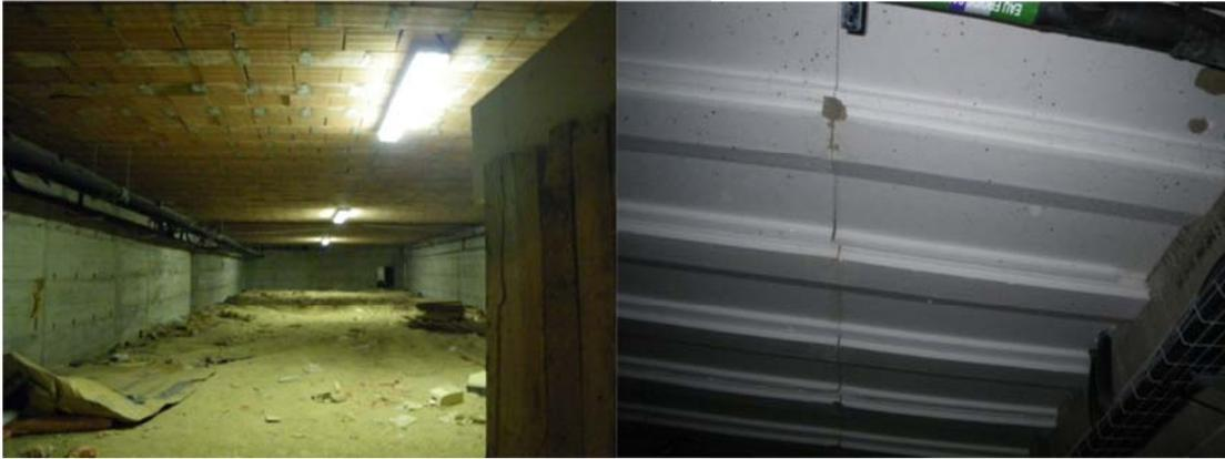
illustration 22 – Exemples de planchers en pièces préfabriquées
