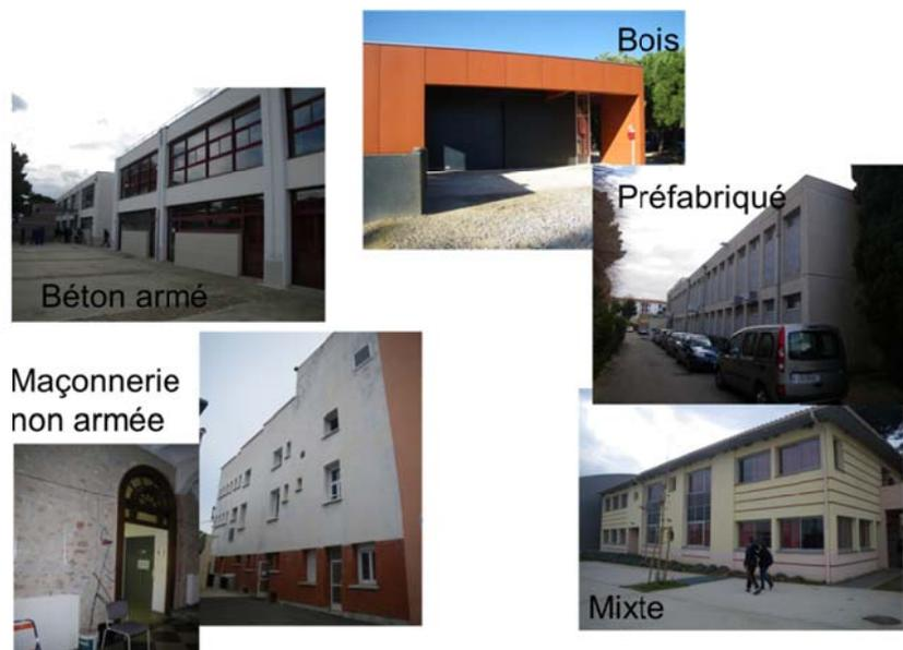
illustration 29 – Exemples de plusieurs modes constructifs (paramètre WD).
