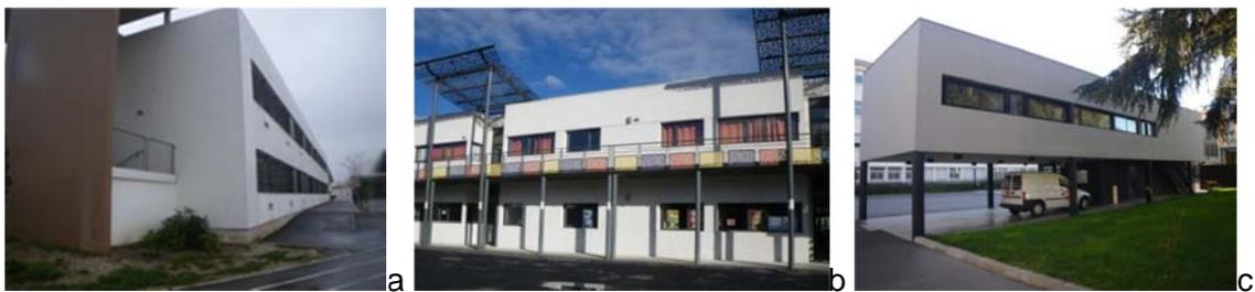
illustration 28 – Paramètre WA, contreventement en élévation. a) voiles continues en élévation, b) décalage d'ouvertures entre le RDC et l'étage et c) transparence du RDC
