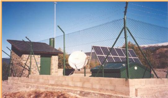
Estación sísmica de Livia. Transmisión por satélite, sistema VSAT
