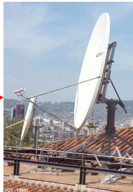
Detail de l'antenne de réception à l'ICC (Barcelone), diamètre de l'antenne HUB 3.8 m
